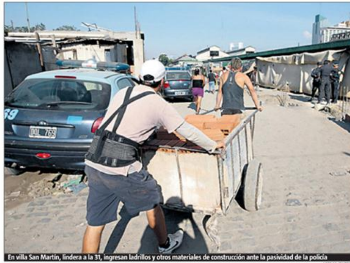
En villa San Martín, lindera a la 31, ingresan ladrillos y otros materiales de construcción ante la pasividad de la policía
